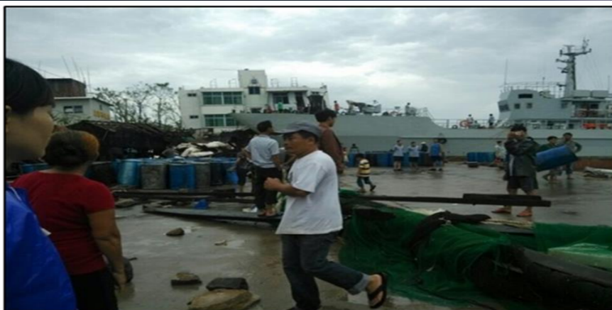
风暴潮将巨轮嵌入文昌铺前镇海事局办公楼
