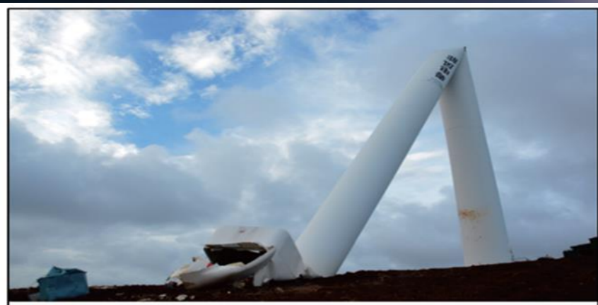
徐闻下桥镇被摧毁的风电塔
